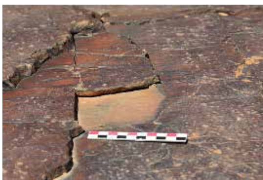
Exemple d'altération de la couche superficielle de la dalle.
